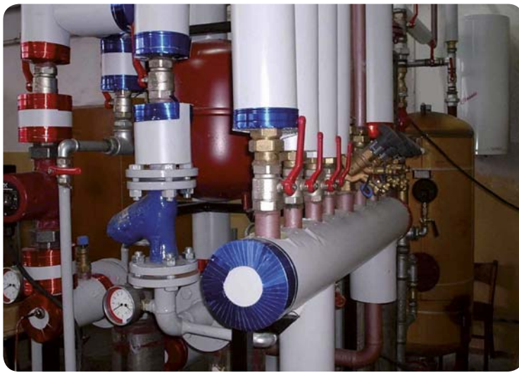
PRZYKŁAD ZASTOSOWANIA Izolacja instalacji grzewczych
