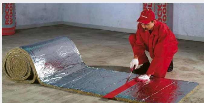
FOT. 411.5. Krok 1 – dokładne zwymiarowanie maty.
