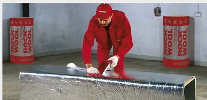
FOT. 411.8. Krok 4 – uszczelnienie taśmą aluminiową połączeń podłużnych i poprzecznych maty.
