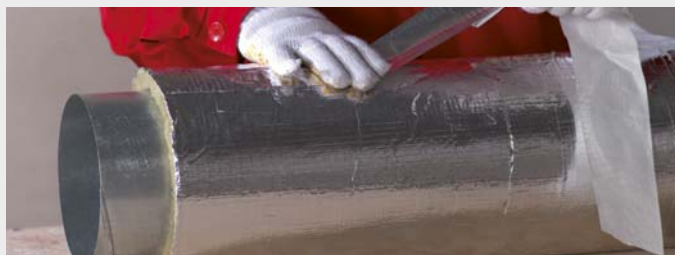
FOT. 411.3. Krok 3 – uszczelnienie taśmą aluminiową połączeń podłużnych i poprzecznych.
