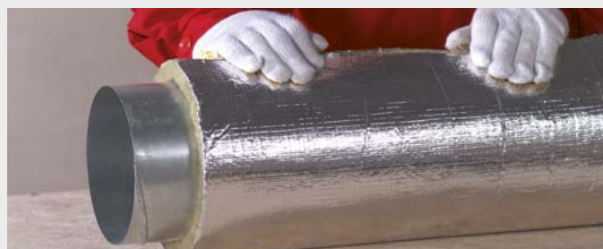
FOT. 411.2. Krok 2 – owinięcie kanału izolacją.
