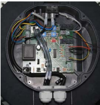
Rys.3: Nastawianie ciśnienia różnicowego przełącznikami dekadowymi
