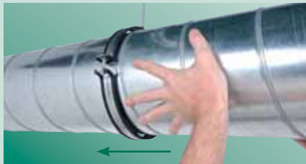
Montaż rur bez problemu z wypadającą okładziną
