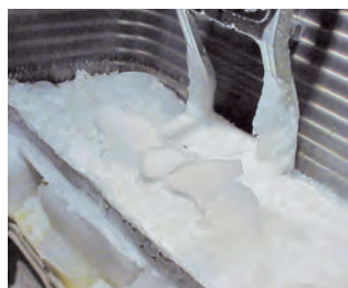
Oblodzenie urządzenia zewnętrznego bez ogrzewania tacy
